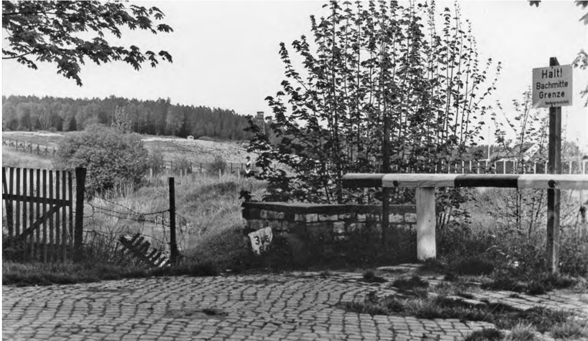
Abbildung 30: Grenze 1977. Die Mauer war noch nicht errichtet und es stand auch noch der Holzturm, ähnlich den Wachtürmen in sowjetischen Gulags.
