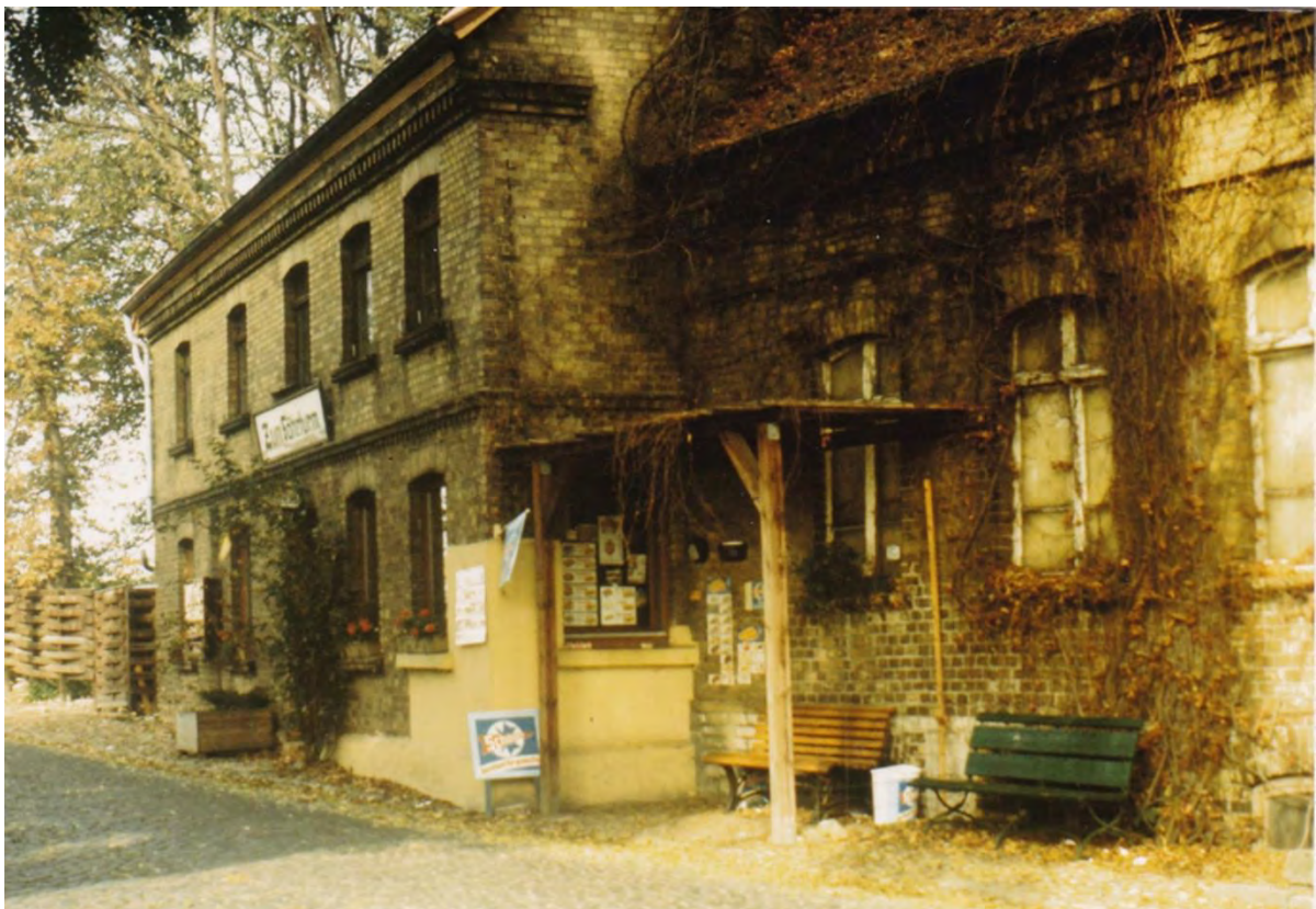
Abbildung 44: Fährturn als Kiosk.
