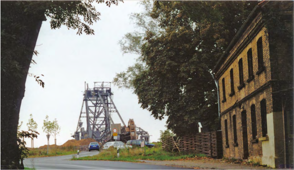
Abbildung 45: Bagger am Fährturn
